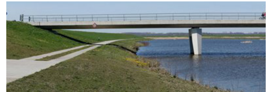
Referentie brug Reevediep: dijktaud loopt onder de brug door
