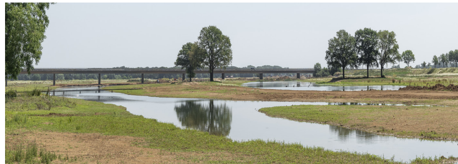
Referentie brug Ooijen Wanssum: brug ondersteunt de landschapsbeleving. De uiterwaard loopt door. Foto: Hans van der Meer.
