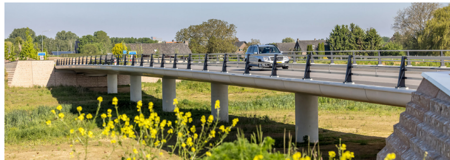
Referentie brug Ooijen Wanssum: transparante brug op 1 steunpunt met smal brugdek, open, horizontale leuning. Foto: Paul Poels.
