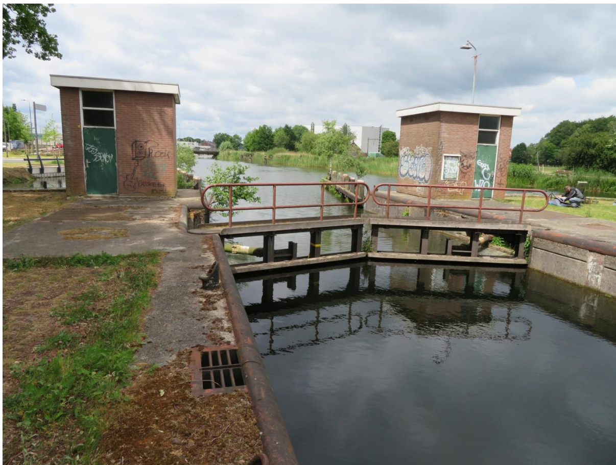
Bovenhoofd met sluisdeuren en rioolschuifgebouwtjes (2020)
