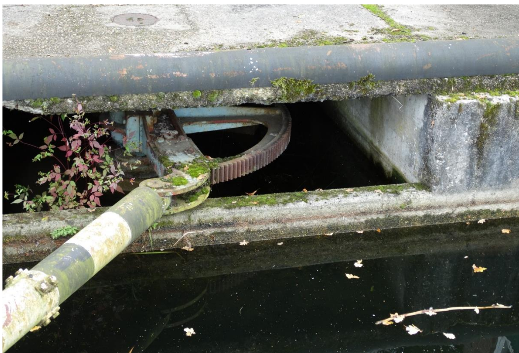
Bewegingswerk sluisdeur met half Panamawiel en trek-duwstang (2014)
