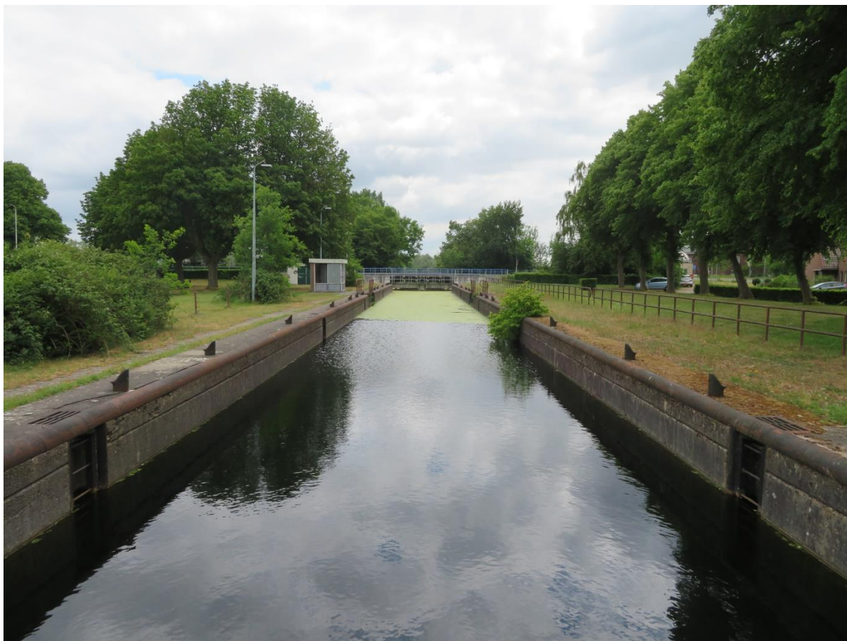
De sluiskolk gezien vanaf het bovenhoofd in de richting van de Zutphensestraatweg (2020)
