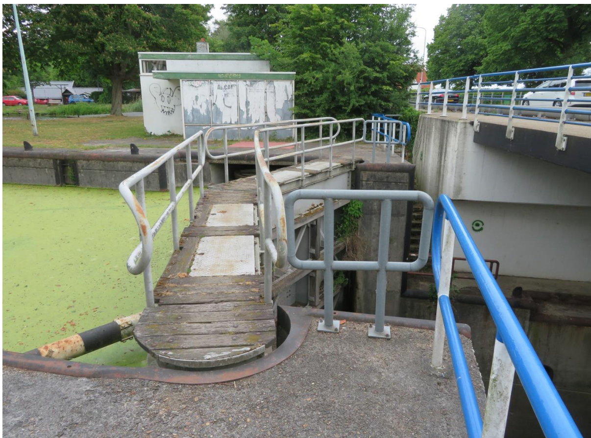
Benedenhoofd met sluisdeuren; op de achtergrond het sluiswachtersverblijf-bedieningsgebouw, rechts de brug in de Zutphensestraatweg over de voorhaven (2020)
