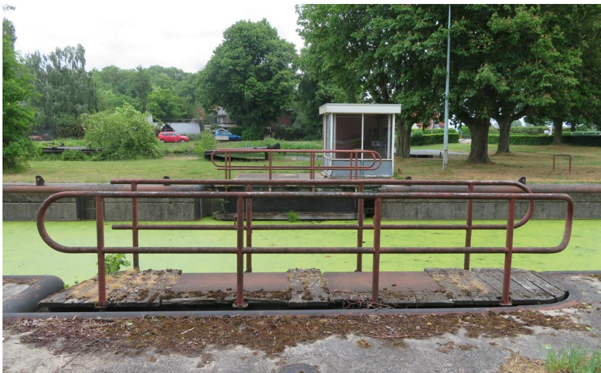
Het tussenhoofd in de sluiskolk (2020)
