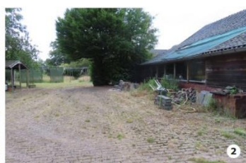
2 Verhard opslagterrein achterzijde kapschuur
