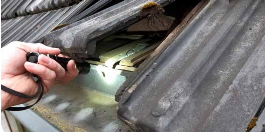
Inspectie van de dakrand > geen sporen aangetroffen.
