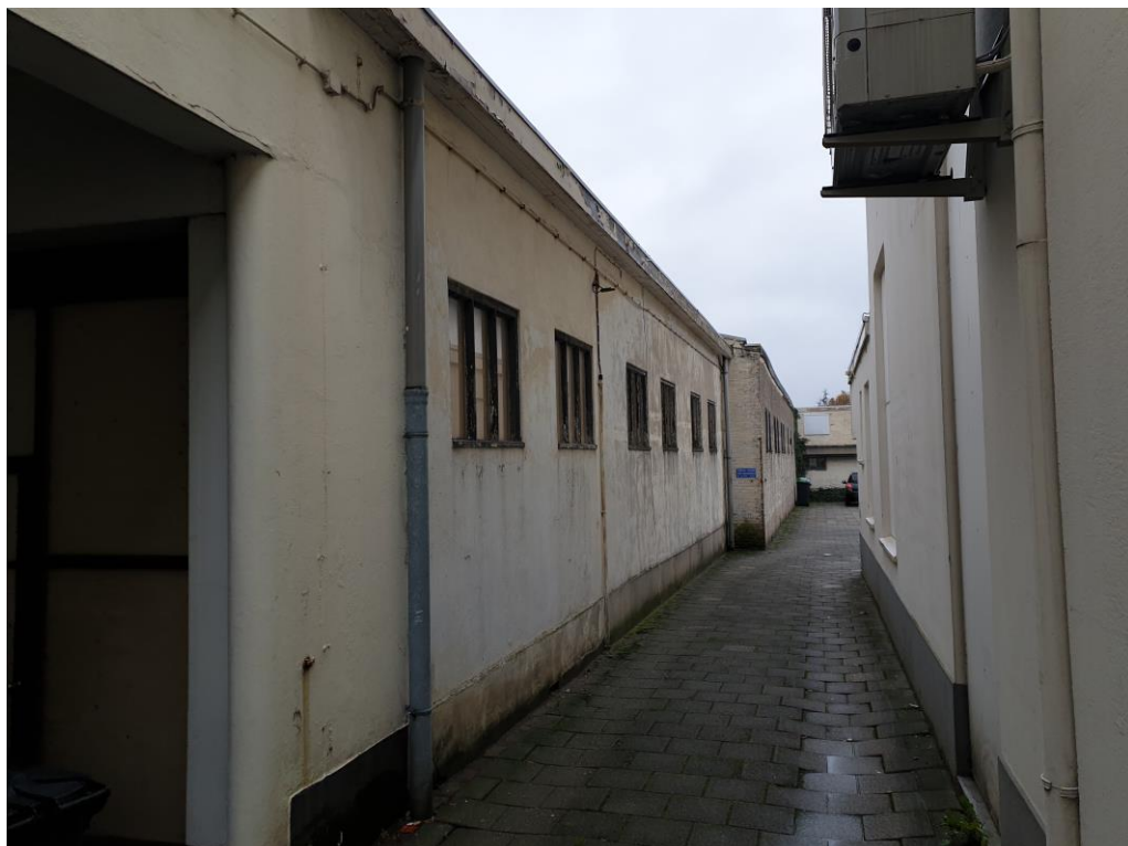
Figuur 2 Het later bijgebouwde gedeelte (nr. 75) bestaat uit gepleisterde en gemetselde muren zonder spouw.
