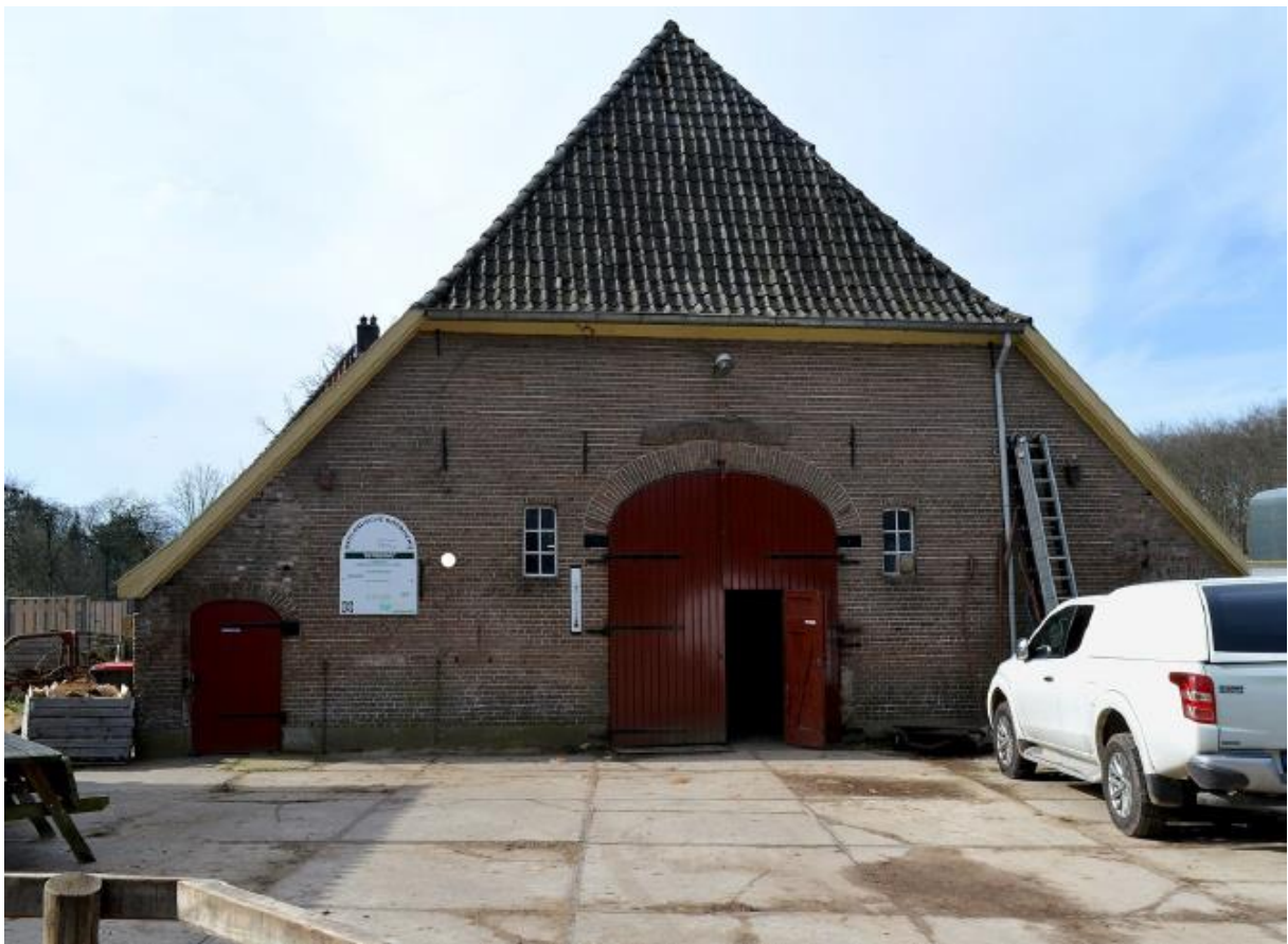
Achtergevel, begin 2023. Foto De Fabryck.
